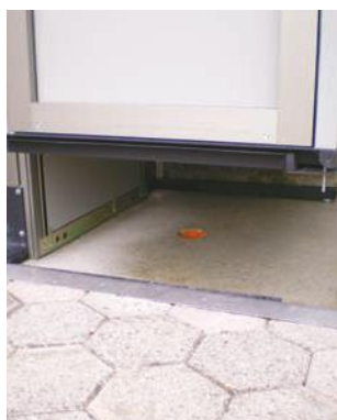
Fossa sotto la piattaforma
