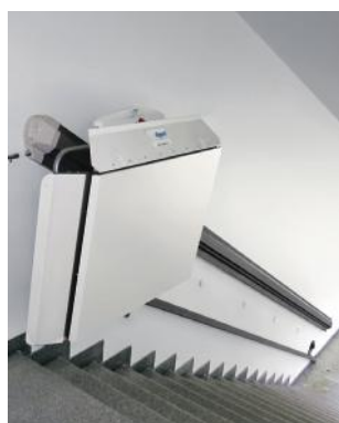
Fermata superiore con piattaforma chiusa
