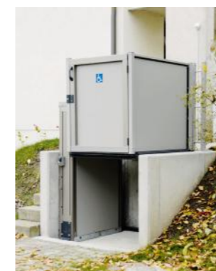
Plate forme en position haute
