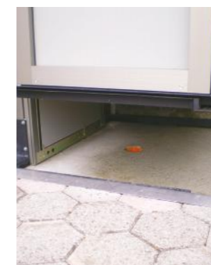
Fosse sous la plate forme
