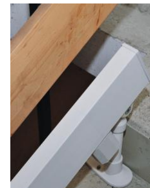
Fin de rail court à l'arrêt du haut
