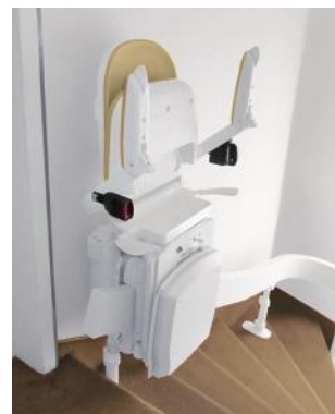
Arrêt du haut - siège replié - l'escalier est libre
