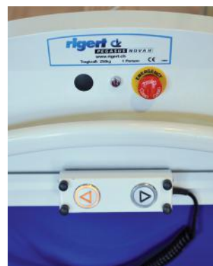
Boîtier de commande déplaçable, main courante continue
