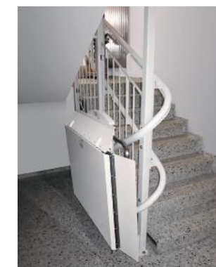
Plate forme fermée, l'escalier est libre
