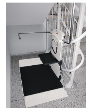
Un accès sans marche sur la plate forme à l'arrêt
