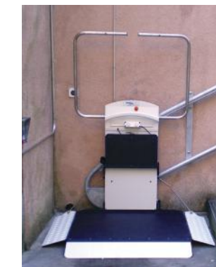
Plate forme avec rampe d'accès latérale
