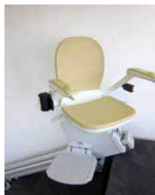
Haltestelle oben – Sitz auf Podest gedreht für sicheren Ein- und Ausstieg
