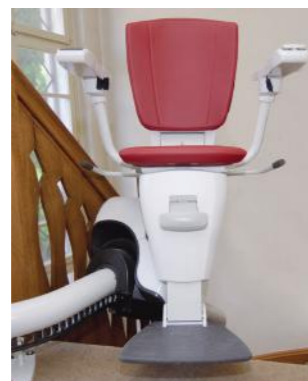
Haltestelle oben Sitz ausgedreht auf Podest
