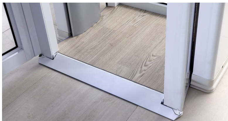
Soglia inclinata e pavimento antiscivolo
