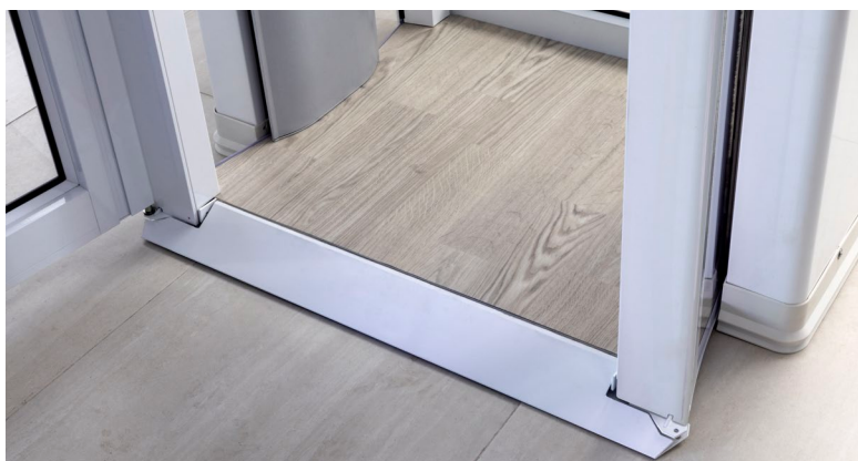
Seuil incliné et revêtement de sol antidérapant
