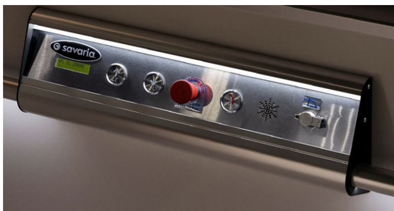
Beleuchtete Drucktasten mit Totmannsteuerung und Diagnosedisplay
